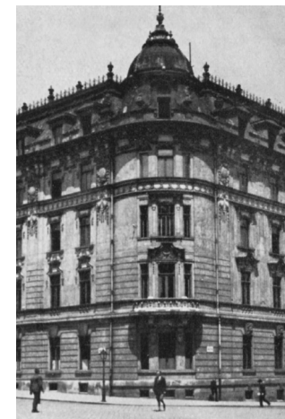
11 A Külügyminisztérium épülete 1935-ben
