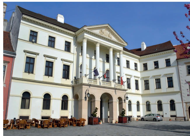
5 A Járásí hivatal (régí vármegyháza) épülete Sopronban
