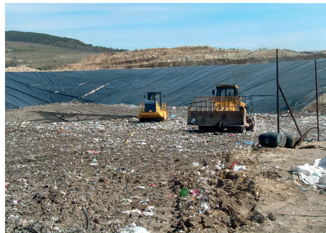
8 Szigetelt hegyvidéki gödörfeltöltéses hulladéklerakó
