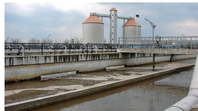
2 Elevelenzipos rendszerű biológiai szennyvíztisztítás, a háttérben rothasztó tornyokkal
