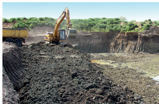
6 Egykori katonai repülőtér környezeti kármentesítése: olajjal szennyezett talaj és talajvíz tisztítása
