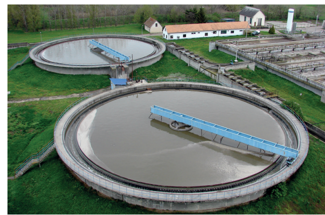
1 Dorr-típusú ülepítők (előtérben) és biológiai szennyvíztisztító medence (háttérben)
